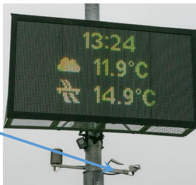
Датчик атмосферных условий (видимость, наличие, тип и интенсивность осадков)
